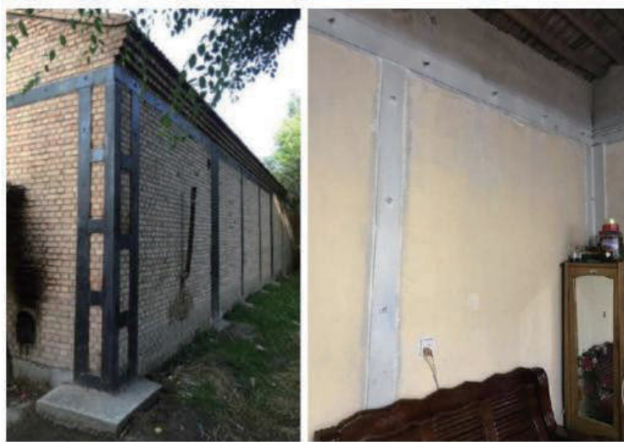
图 7-15 型钢带整体加固示意图
