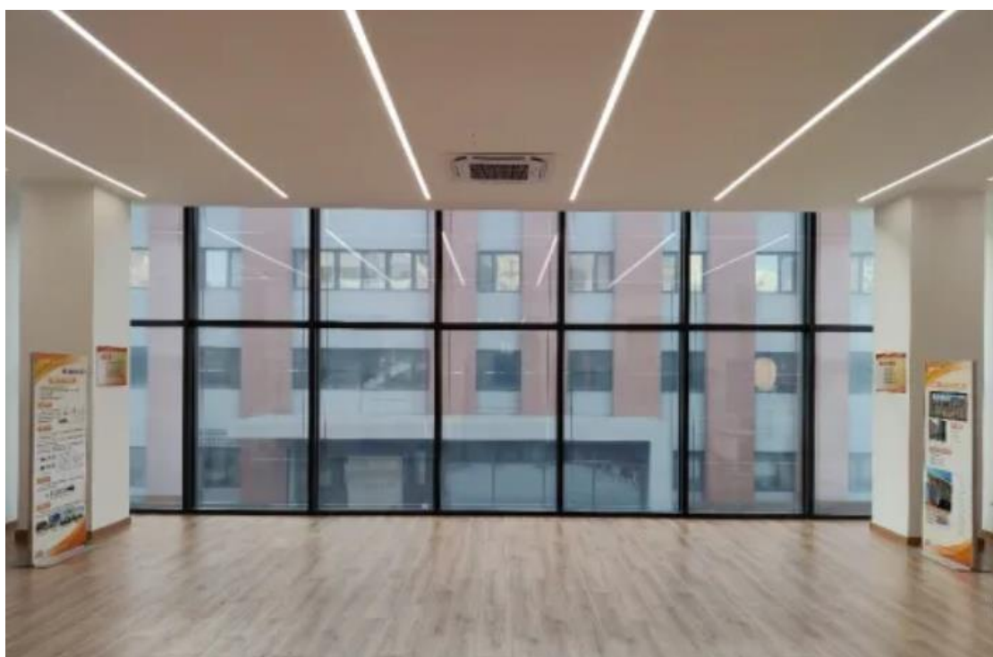
中国建研院光电建筑南向可透光光伏幕墙
