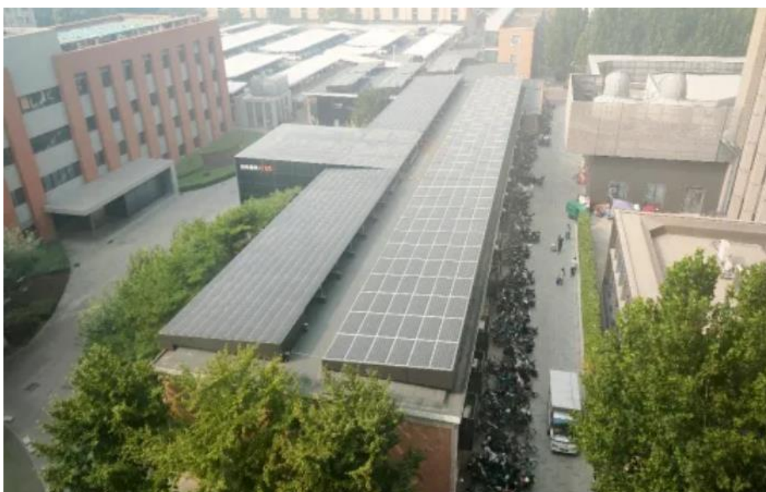
建研院光电建筑屋面太阳能光伏阵列
