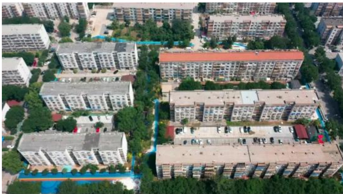
昌盛园社区老旧小区改造航拍图（一期改造后）
