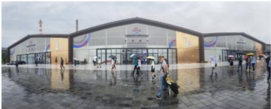
石景山体育馆 首钢服贸会场馆 改造通风、给排水系统等配套设施，增加应急隔离房间储备
