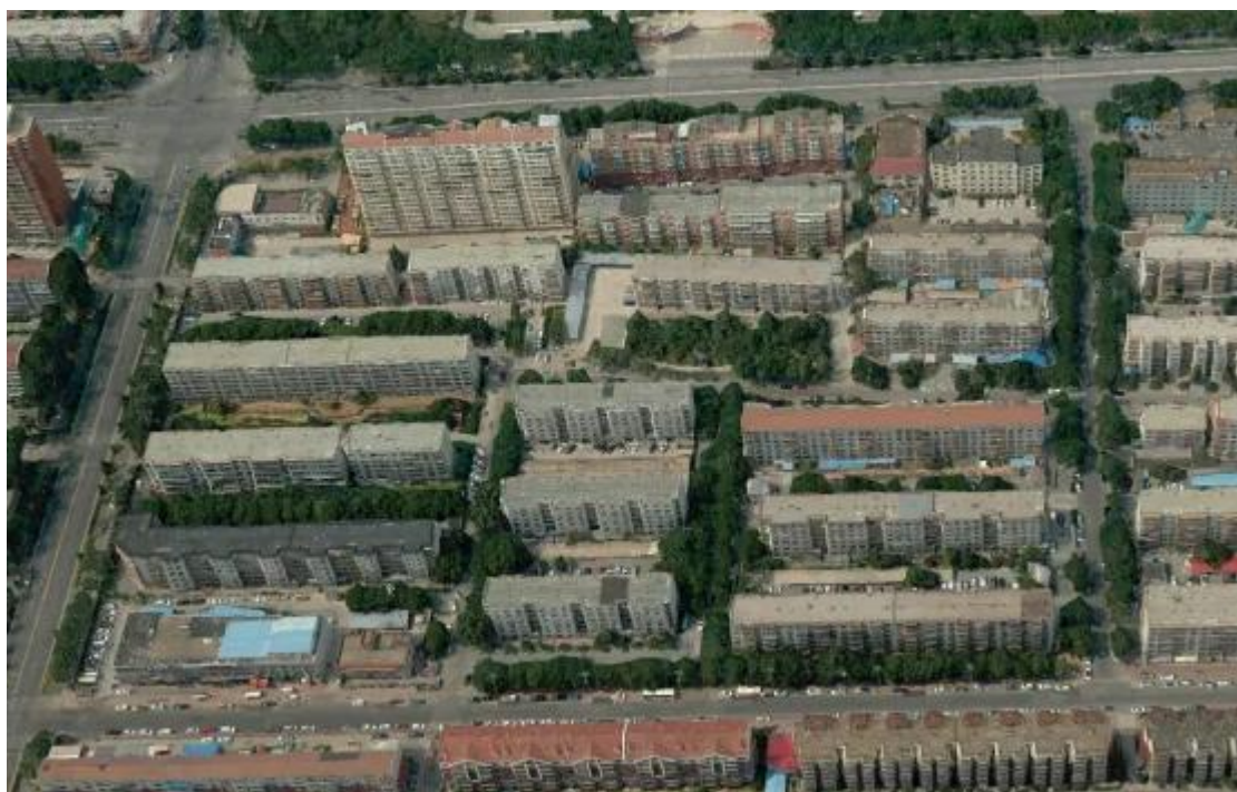
昌盛园社区老旧小区改造航拍图（改造前）
