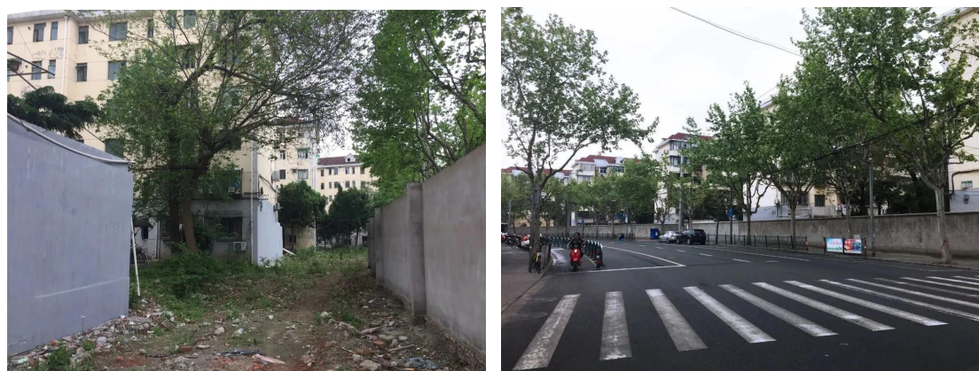
改造前原状，围墙里（左图）；改造前原状，围墙外（右图）
