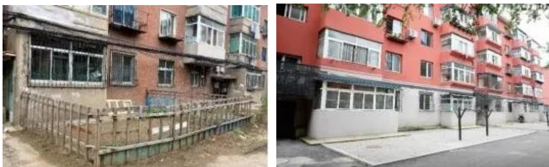
拆违及外墙改造前后
