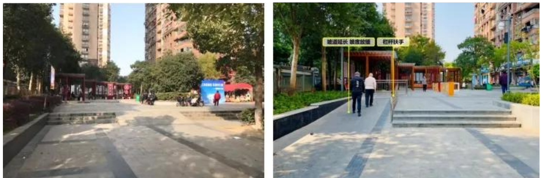
无障碍改造前后对比图（拉长坡道，减缓坡度，增加扶手）
