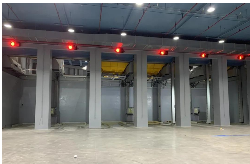
运转大厅改造前后
