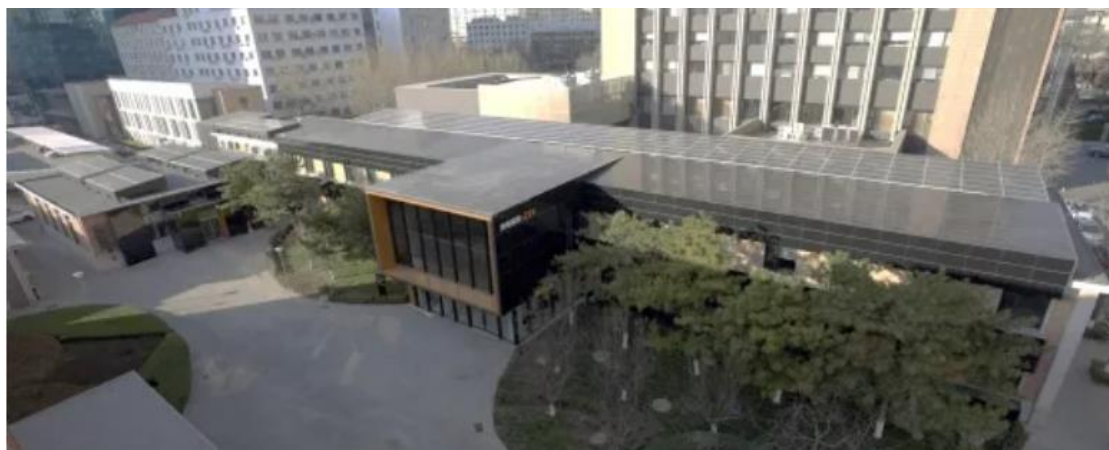
建研院环能院光电建筑（改造后全景）
