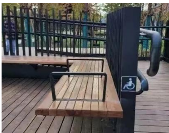
示范段扶手加设、城市道路出入口无障碍改造
