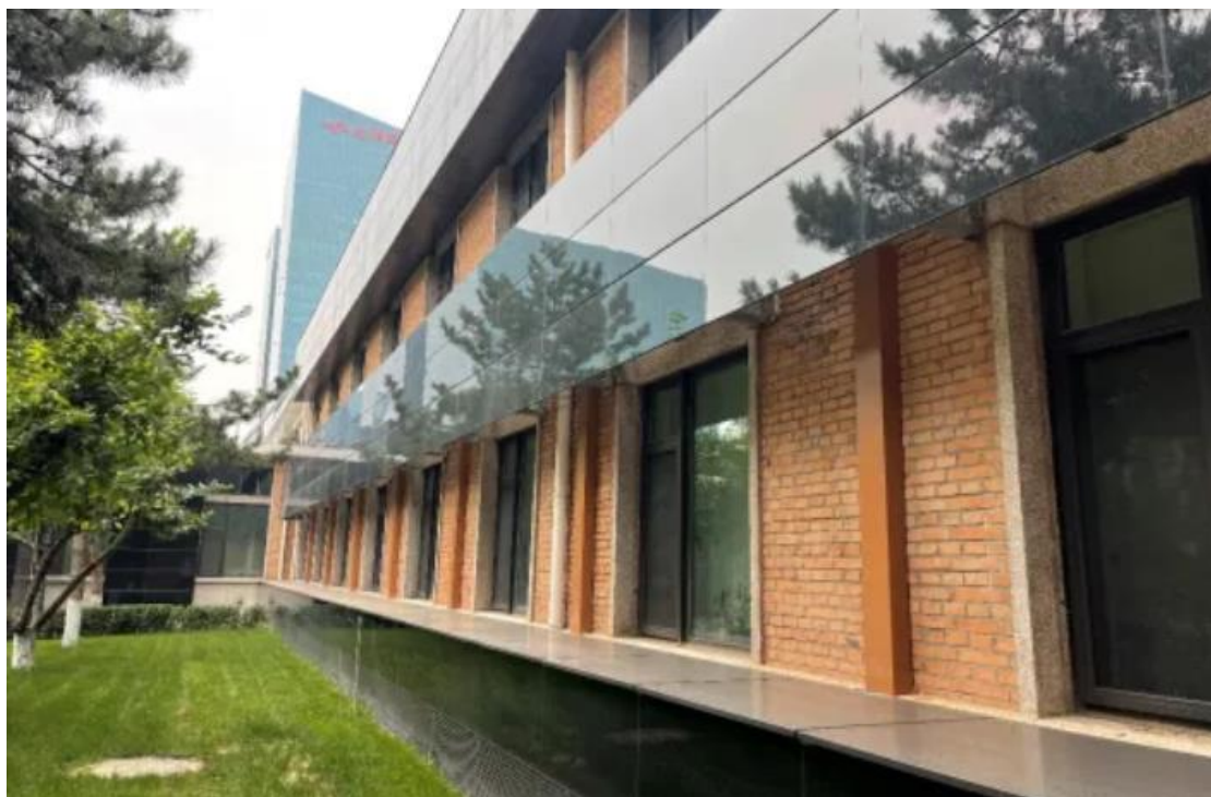
中国建研院光电建筑南立面太阳能光伏阵列
