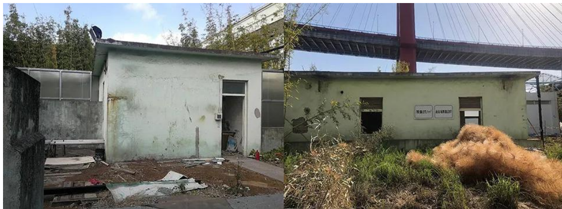
改造前现状废弃监测站站房
