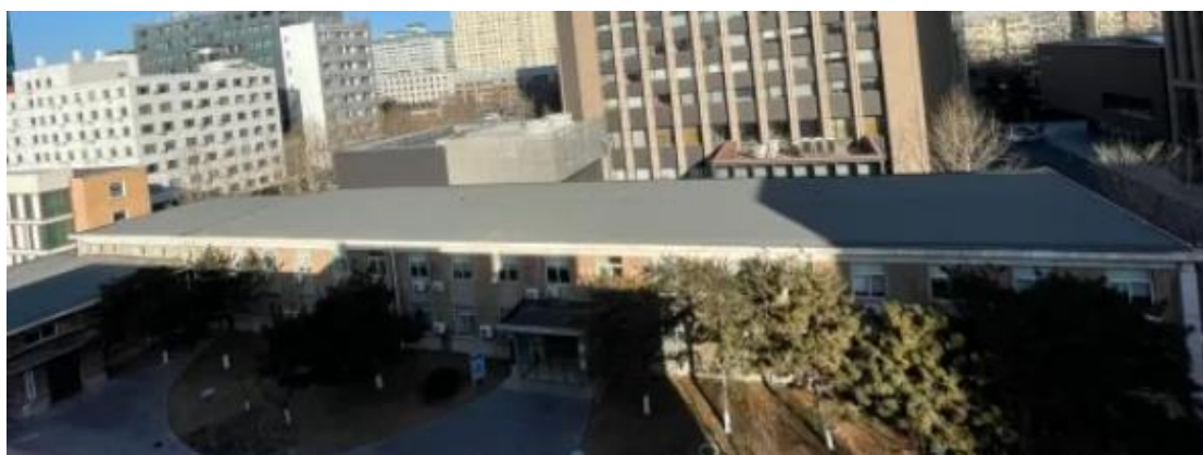
建研院环能院原办公楼（改造前屋面）
